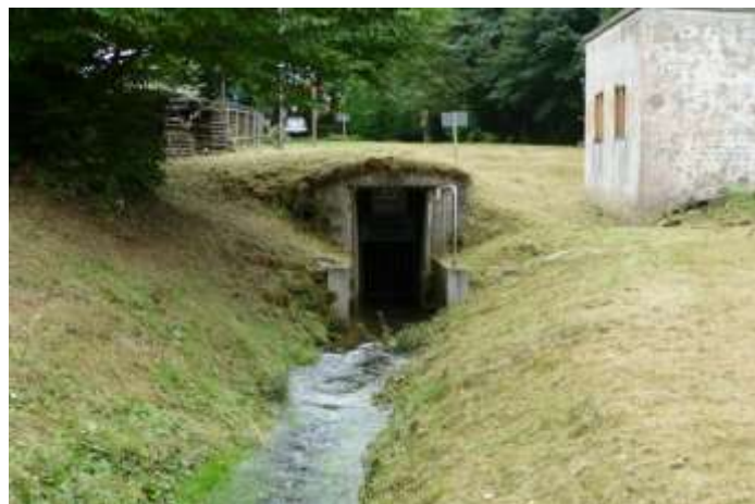
Abbildung 26: Mundloch des Tiefen Sauberger Stollns.
