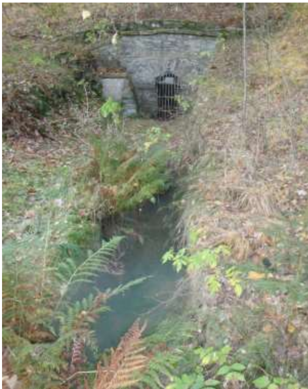
Abbildung 17: Mundloch des VGS mit Grubenwasseraustritt.
